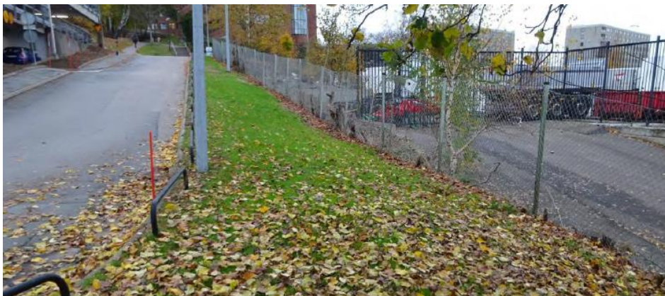
Figur 10. Bild mot norr som visar slänt mellan befintligt parkeringshus i väst och parkeringsyta i östra delen av planområdet (WSP, 2022)
